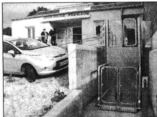
Ascenseur permettant l'accessibilité aux PMR
